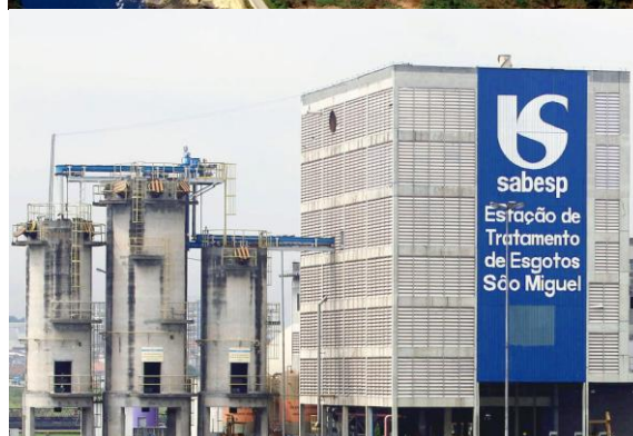
Kläranlagen von Sabesp, São Paulo
